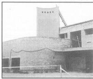
Budynek warszawskiego Zakładu Kremacji MPUK. Stan z czerwca br.
